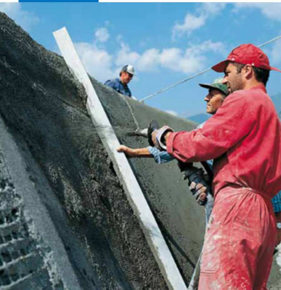
Механизированное нанесение MapegROUT T40
