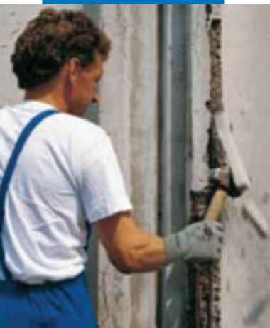
Удаление поврежденного бетона
