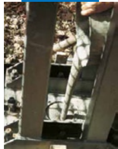
Анкерное крепление с помощью раствора Mapefill
