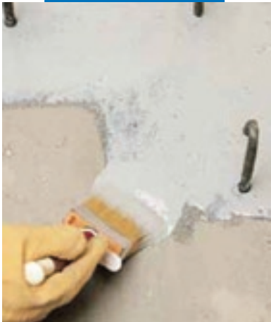
Нанесение Eporip кистью на рабочий шов бетонирования
