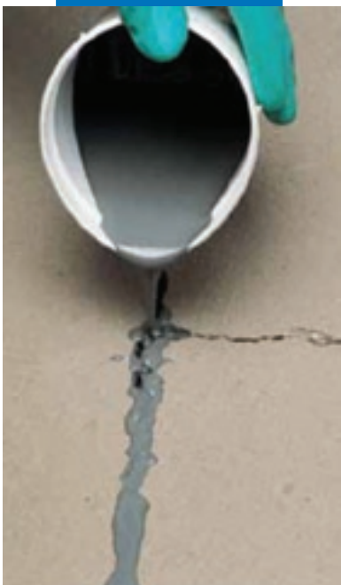
Ремонт трещины в цементной стяжке с помощью Eporip
