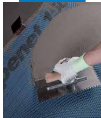
Нанесение Mapelastic на Mapenet 150
