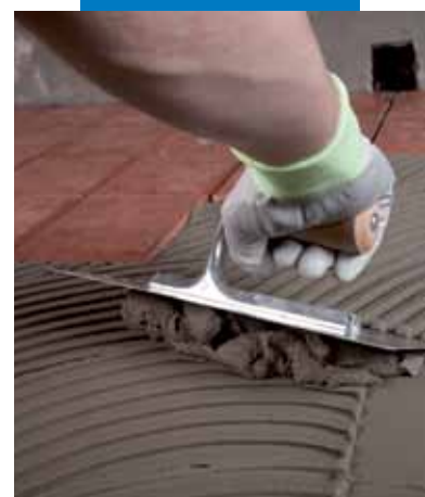
Нанесение Granirapid на гидроизоляцию Mapelastic на террасе
