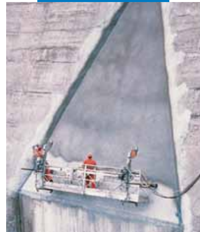
Нанесение Mapelastic на дамбу распылением
