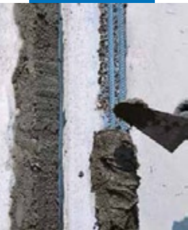
Нанесение раствора мастерком
