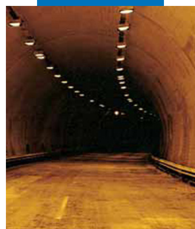
Нанесение белого Planiseal 88 напылением в автодорожной галерее
