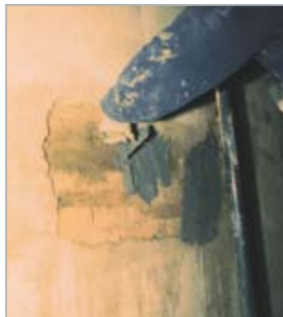
Рис. 5.5 – Ремонт отслоившейся штукатурки с помощью NIVOPLAN+PLANICRETE
