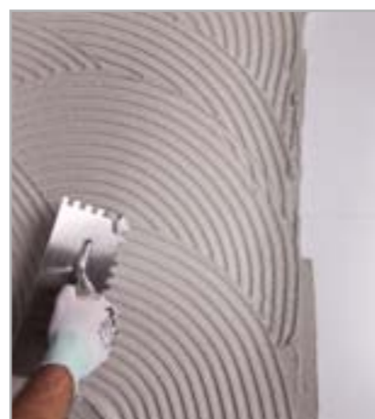
Рис. 5.15 – Нанесите первый слой выравнивающего и разглаживающего раствора
