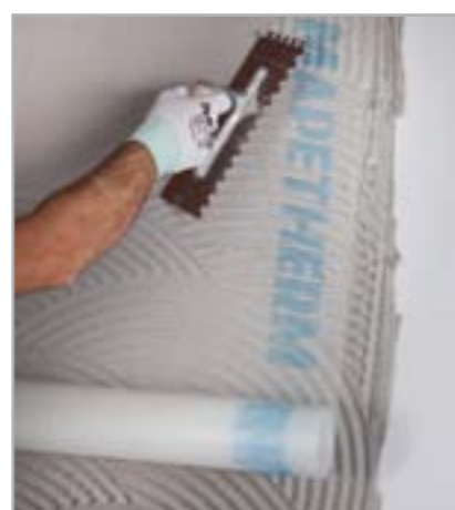
Рис. 5.16 – Поместите на поверхность МАРЕТHERM NET
