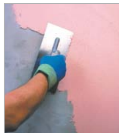
Рис. 5.18 – Нанесите слой отделочной штукатурки
