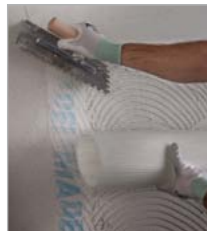
Рис. 5.17 – Перекройте края сетки, как минимум, на 10 см
