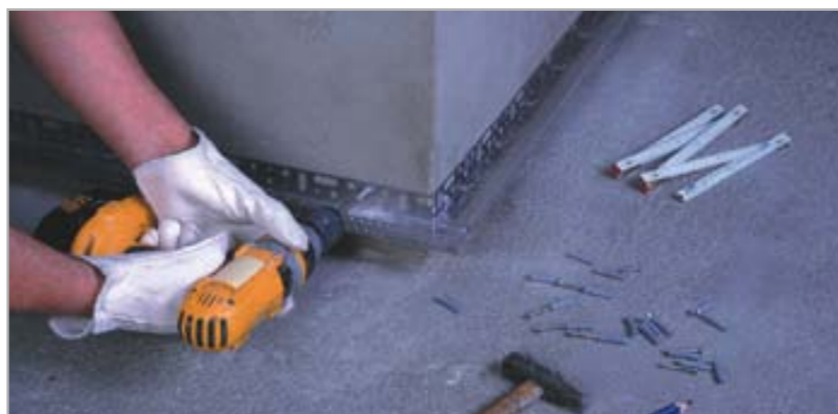
Рис. 5.7 – Крепление поддерживающих профилей на месте, посредством дюбелей
