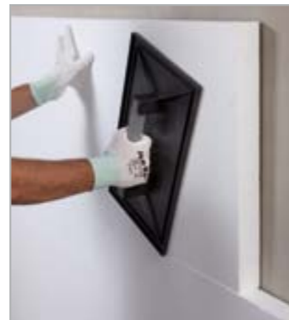
Рис. 5.11 – Придавите панель гладилкой
