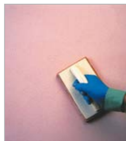
Рис. 5.19 – Разгладьте поверхность штукатурки губчатой гладилкой SPONGE FLOAT
