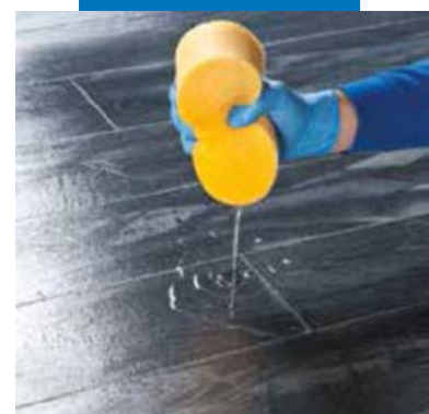
Смачивание поверхности перед очисткой
