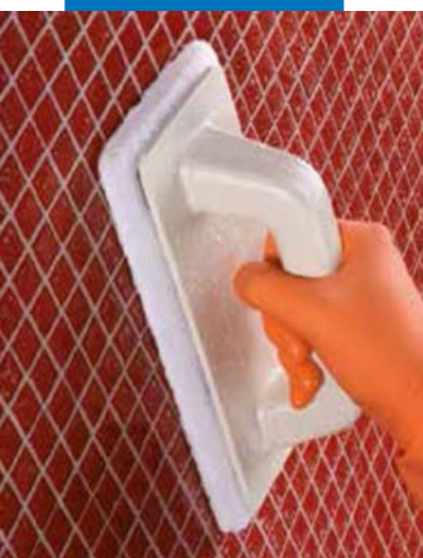
Очистка стеклянной мозаики влажной абразивной губкой Scotch Brite®
