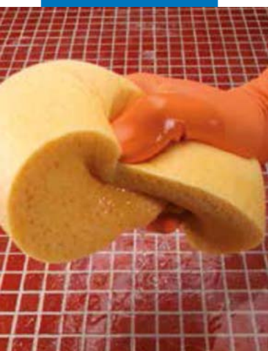
Смачивание поверхности перед очисткой
