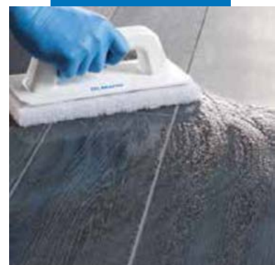
Очистка швов специальной губкой Scotch-Brite®
