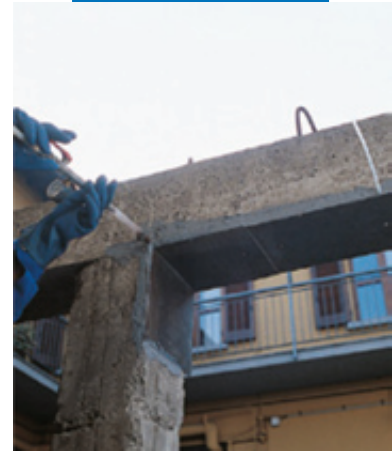
Ремонт балки инъекцией Eроjet
