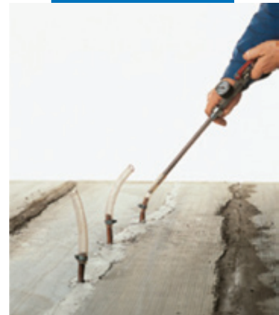
Восстановление горизонтальной конструкции инъекцией Eроjet
