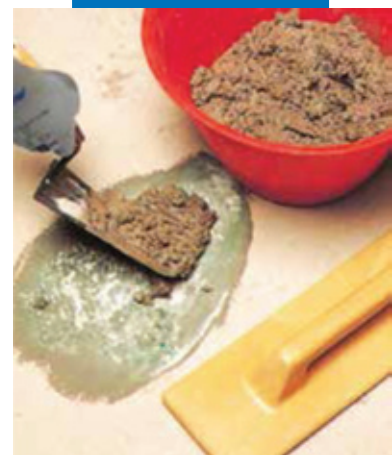
Ремонт пола: нанесение строительного раствора
