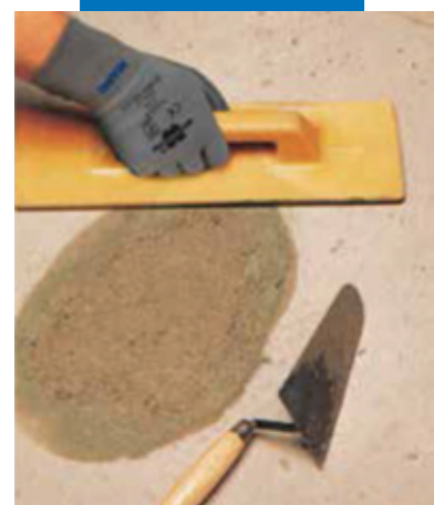
Ремонт пола: заглаживание поверхности
