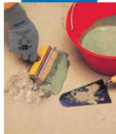
Ремонт пола с нанесением цементного раствора
