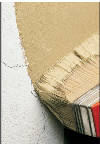
Фото 17. Нанесение Elastocolor Paint.
