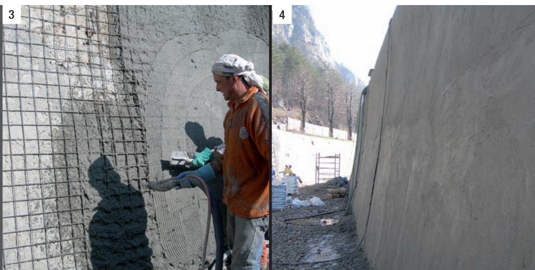
Фото 3. Нанесение Mapegrout Easy Flow механизированным способом.
