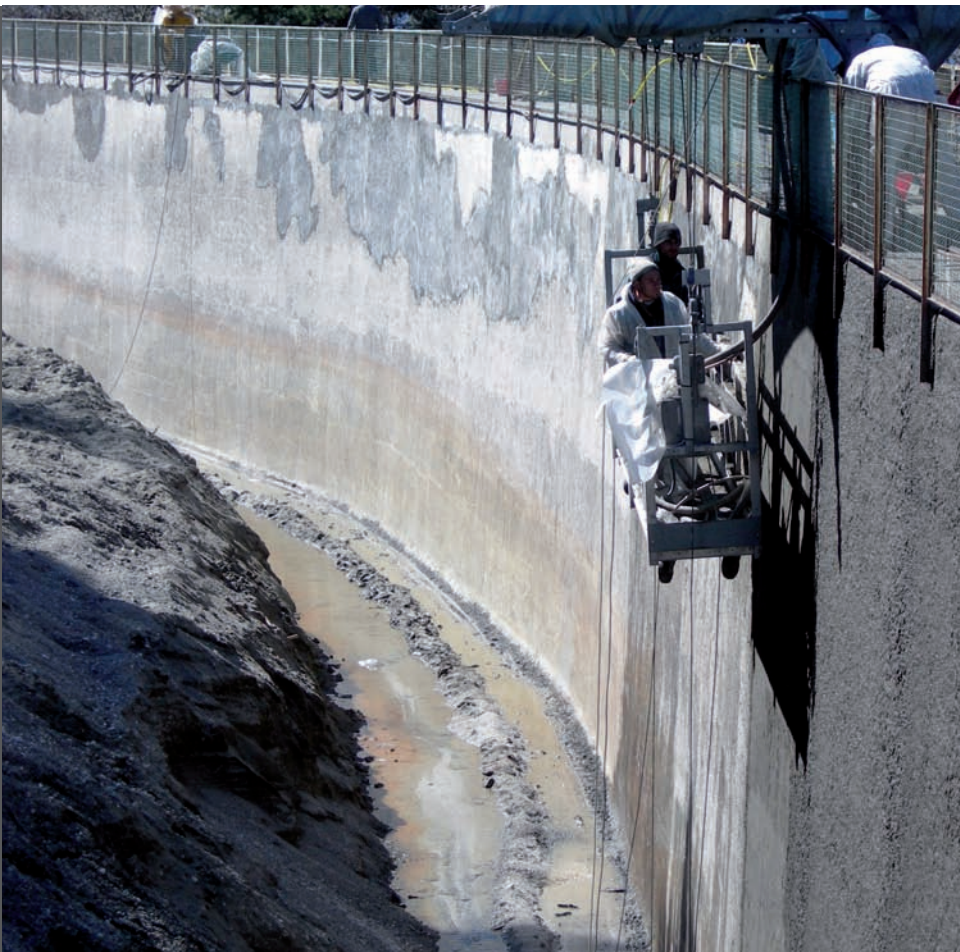
Фото 7. Нанесение Mapegrout VM.
