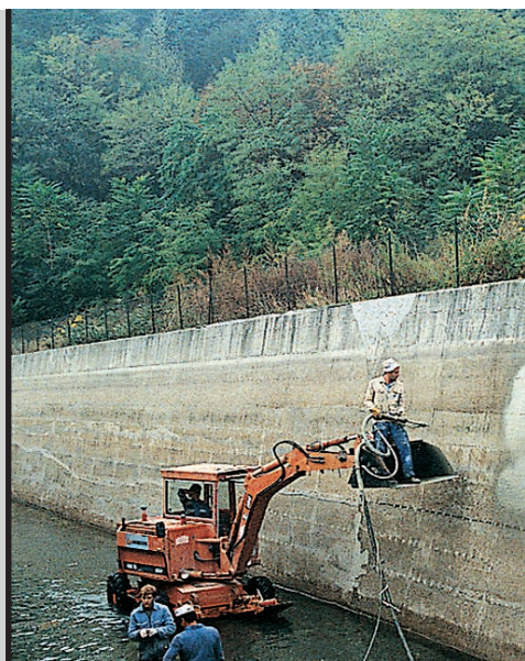
Фото 16. Нанесение Idrosilex Pronto.
