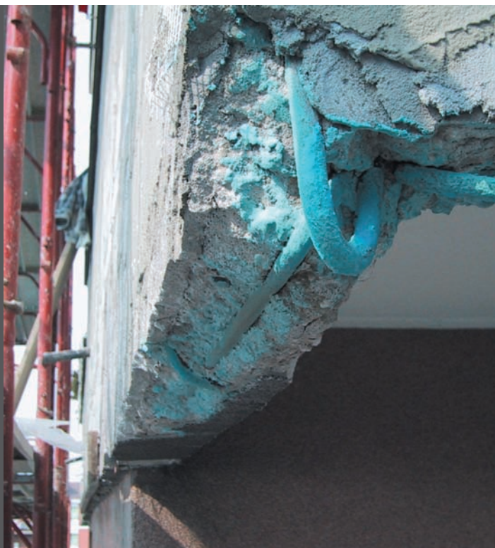
Фото 1. Нанесение антикоррозионного раствора на арматурные стержни.
