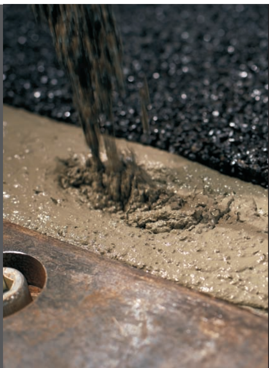
Фото 10. Заполнение шва с использованием Mapegrout Hi-Flow TI20.
