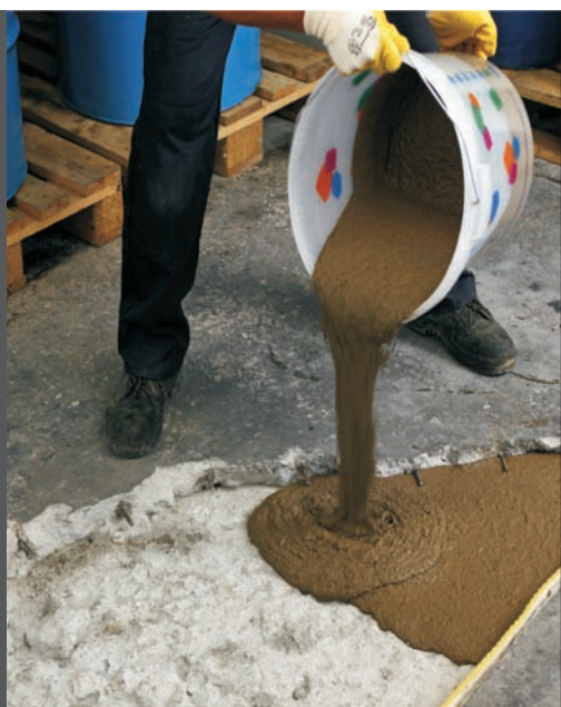
Фото 11. Ремонт полов использованием Mapegrout SV Fiber.
