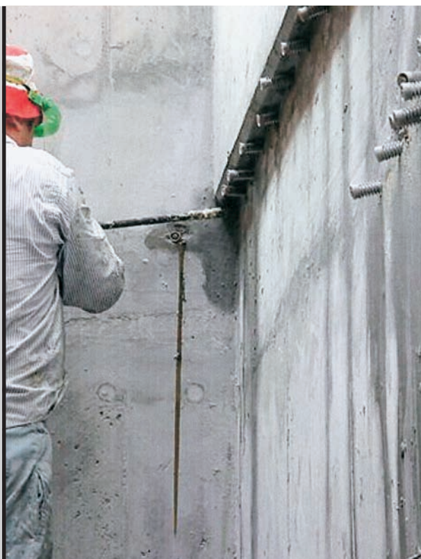
Фото 13. Инъекцирование Foamjet F.
