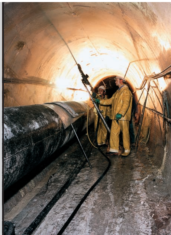
Фото 14. Инъекцирование Foamjet T.
