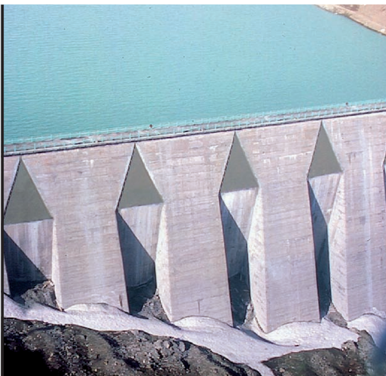
Фото 15. Конструкция, гидроизолированная при помощи MAPELASTIC.
