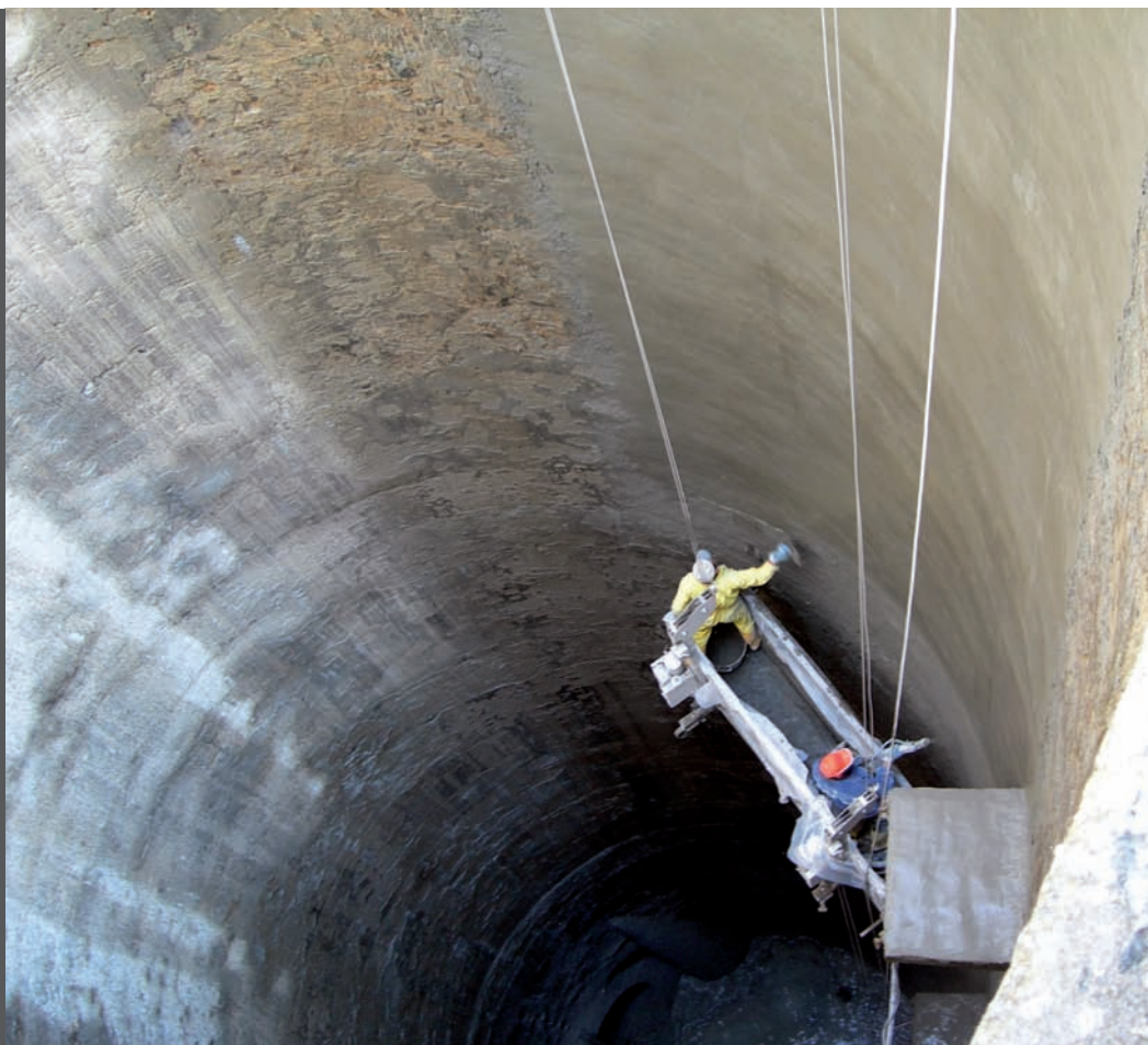
Фото 6. Конструкция, отремонтированная при помощи Mapegrout T60 .
