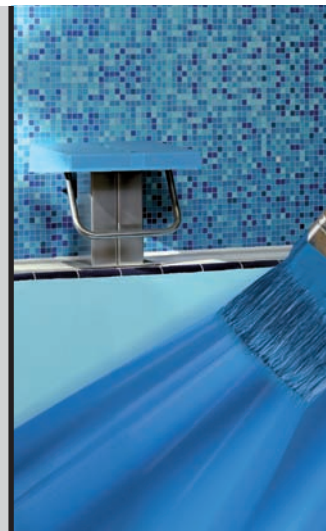
Фото 18. Нанесение Elastocolor Waterproof.
