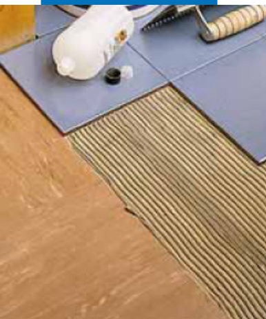
Укладка нового покрытия поверх существующего из ПВХ
